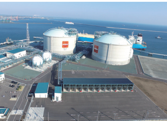
八戸LNGターミナル
