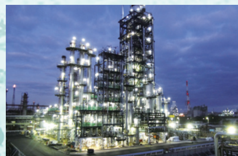
HS-FCC実証化装置(構造物の高さ約70m)
